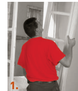
1. Dégondage des ouvrants.
