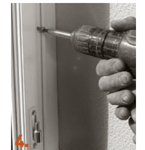
4. Fixation du nouveau dormant par vérins réglables ou par vissage en applique et réalisation d'une étanchéité périmétrale.
